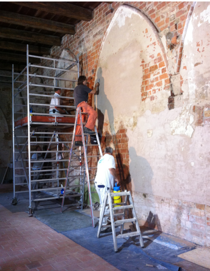
Konrad Dazer und Mitarbeiter der Betriebe von Uli Zuhrt und der Prenzlauer Denkmalpflege GmbH während der Ausführung des restauratorischen Verputzes im Laienrefektorium. Jan Raue, 2017.
