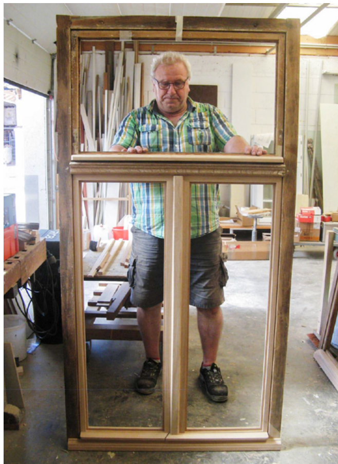
Oben links: Nord- und Westfassade des „Schweizer Hauses“ nach erfolgter Sanierung. Farbgebung nach restauratorischem Befund. Janine Sempff, 2017. Oben rechts: Ecke des Westgiebels vor der Anbringung der neuen Schindeln. Harald Schwalm, 2016. Unten links: Aufnahme der Holzschäden am Balkon. Harald Schwalm, 2014. Unten rechts: Historisches Eichenholzfenster nach erfolgter Reparatur. Harald Schwalm, 2016.
