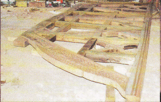
Rekonstruktion des Renaissance-Giebels der Bücherei von Echzell in der Werkstatt
