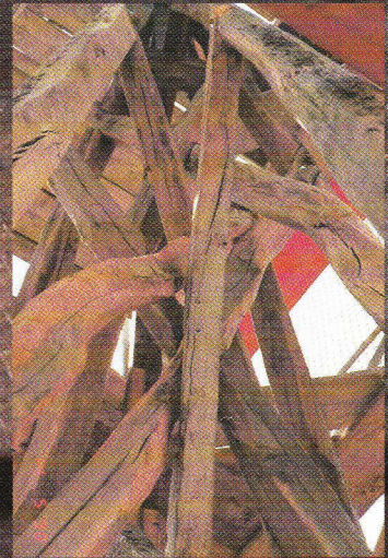
Reparaturarbeiten am gotischen Kirchturm von Leidhecken mit alten, geschwungenen Eichenhölzern.
