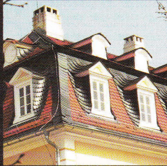
Erneuerung der barocken Gauben im Kavalierbau, Schloß Wilhelmsbad
