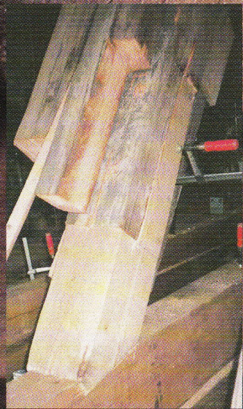
Sanierte Knotenpunkte an Sparren und Gebindestreben in der evangelischen Kirche in Rodenbach.
