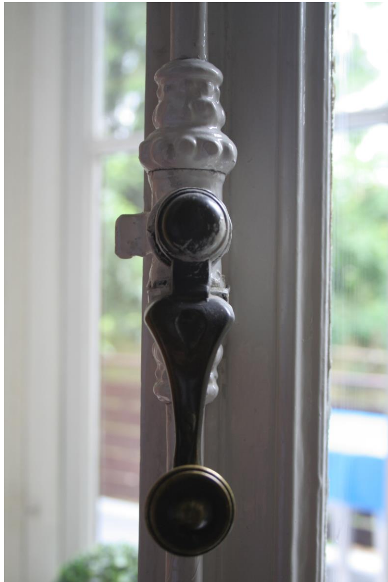
Bauzeitliche Basküleverriegelung an der Innenseite des inneren Fensters.
