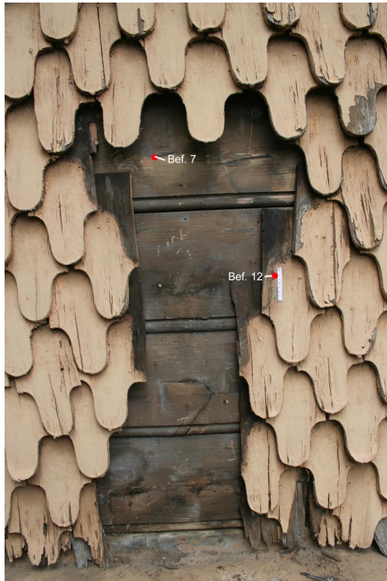
Befundübersicht Befunde 7 und 12 an der Holzverschindelten Südfassade.
