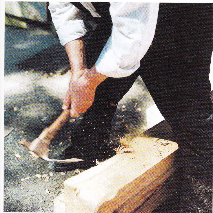
Mit dem Dechsel wird das Holz beschlagen, d. h. aus den runden Stämmen werden vierkantige Hölzer gearbeitet.
