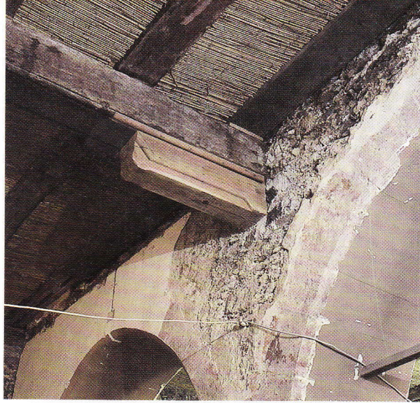
Das Sattelholz dient als Stütze eines sogenannten Unterzuges, eines langen Deckenbalkens.
