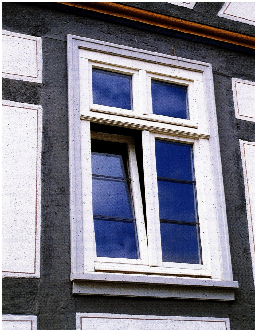
Fenster in Kippstellung bewirken keine effektive Durchlüftung von Räumen. (Foto: ZHD, Stein)
