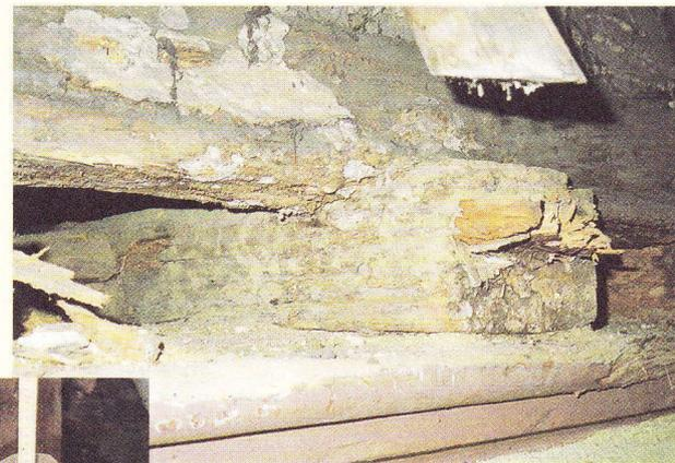
Oben: Durch Fäulnis zerstörtes Konstruktionsholz
