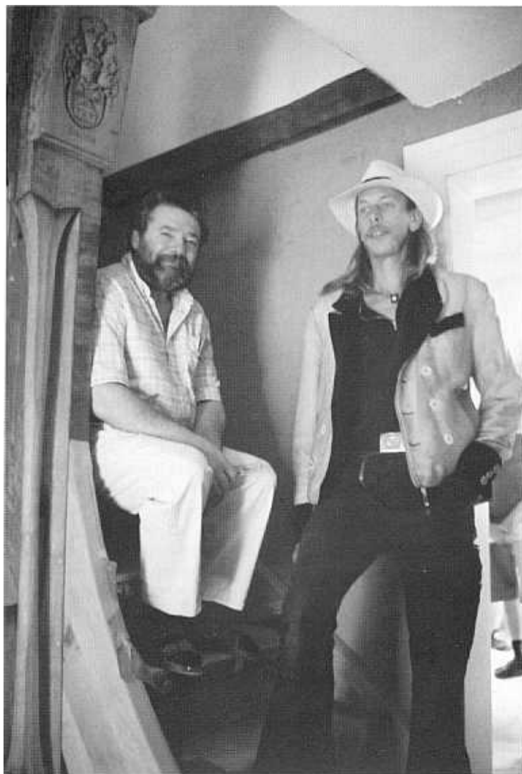
88 Andreas Haller (links) schnitt aus der Eichenstütze an der Treppe eine Haltestange und das Wappen des Eigentümers heraus, Thomas von der Recke besserte die Fensterrahmen und Türfüllungen aus und baute sie wieder ein. Foto Richter
