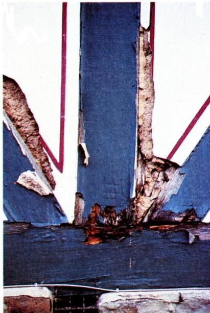
*Holzerstörung durch behinderte Wasserdampfdiffusion infolge eines Beschichtungstoffes, der wesentlich zu dick aufgetragen worden war.*
