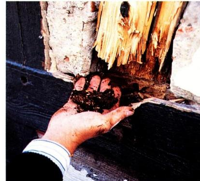
*Fachwerk wenige Jahre nach der Freilegung. Das Fachwerkholz ist in einem desolaten Zustand und kann mit der bloßen Hand entnommen werden. Hier kommen zwei Faktoren zusammen: 1. Fehlender Wetterschutz durch Entfernung der Verschindelung, 2. Zu dicker und damit diffusionshemmender Anstrich. (Foto: ZHD, Veit)*
