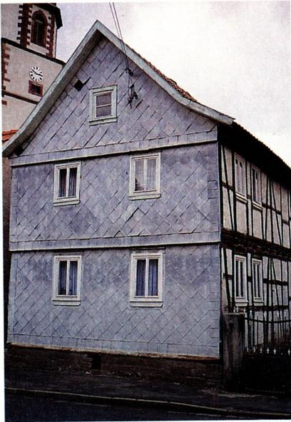
Wetterschutz eines Westgiebels mit einer historischen Blechverschindelung. Die Wetterseite wird hierdurch sicher vor Durchfeuchtung geschützt.
