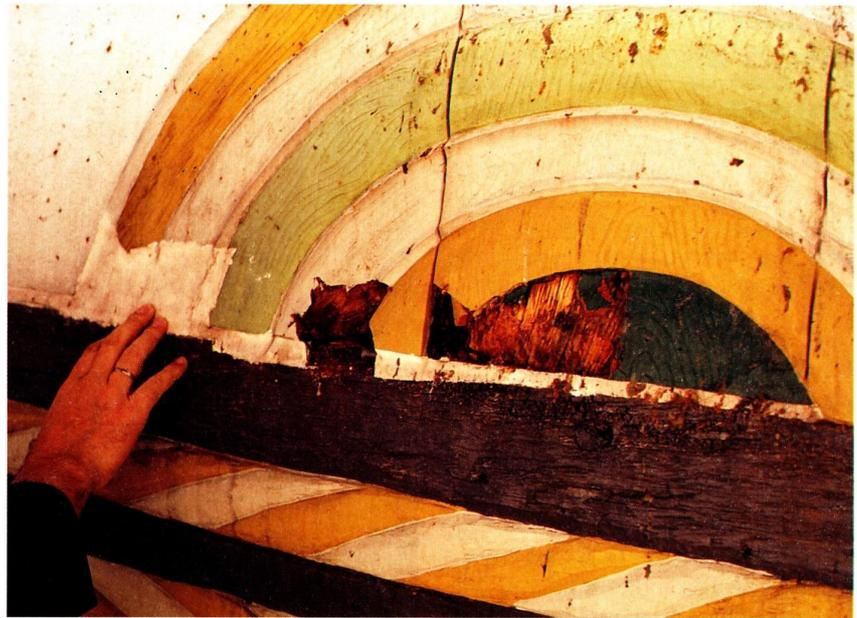
*Während einer Sanierung wurde die abgebildete Holzrossette mit einer Spachtelmasse nachmodelliert und zusätzlich mit einem dicken Anstrich überstrichen. Der gezeigte Schaden trat nur kurze Zeit später auf. (Foto: ZHD, Gerner)*
