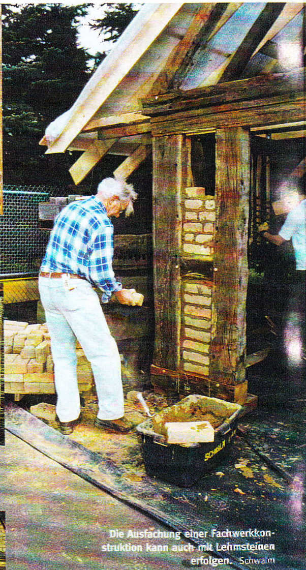
Die Ausfachung mit Lehmsteinen ist abgeschlossen. Deutlich zu sehen: Der Abstand zu den Balken, der noch Platz für den Putz lässt, sodass alles bündig abschließt. Schwalm
