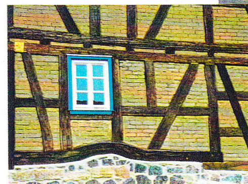
Die Ausfachung mit Lehmsteinen ist abgeschlossen. Deutlich zu sehen: Der Abstand zu den Balken, der noch Platz für den Putz lässt, sodass alles bündig abschließt. Schwalm
