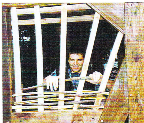
Ein Flechtwerk aus Holz ist eine traditionelle Ausfachungsmethode für Fachwerkkonstruktionen. Schwalm
