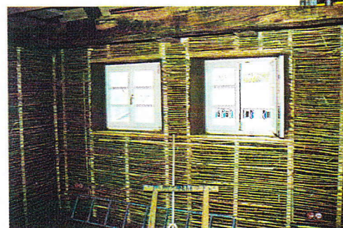
Sind die Holzausfachung und das Strohgebilde im Innern angebracht, kann alles mit Lehm verputzt werden. Schwalm
